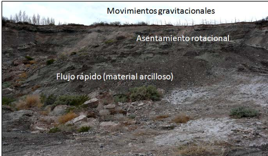
Figura 4. Sector del frente de barda afectado por movimientos gravitacionales.
